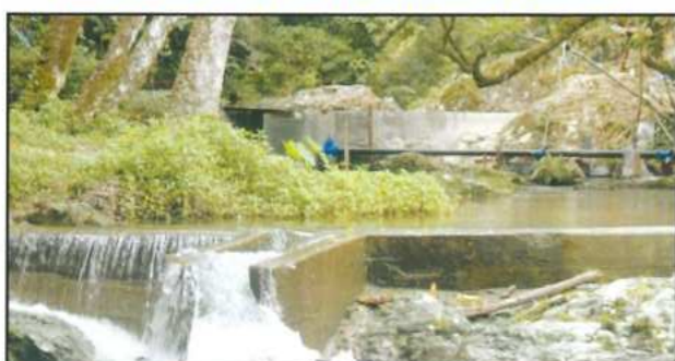
Au premier plan l'ancien captage, au fond le nouveau
