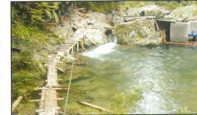
Aménagement pour les travaux à Mia
