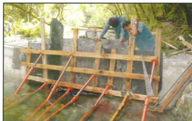
Les travaux du captage du Mia
