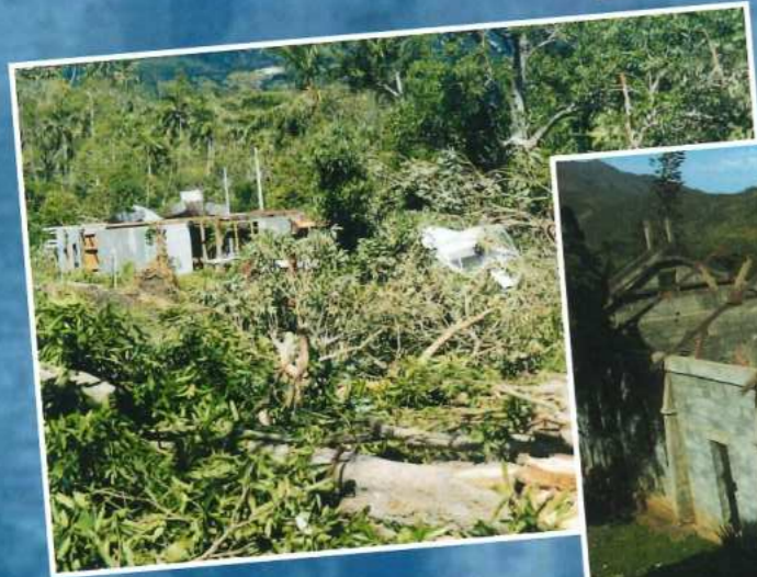
Dégâts à Gélima...
