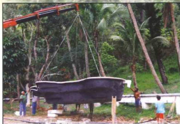
L'installation de l'un des quatre nouveaux bassins du site
